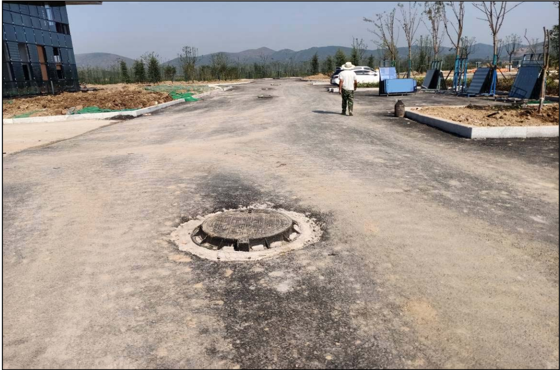
路基工程区服务区雨水口
