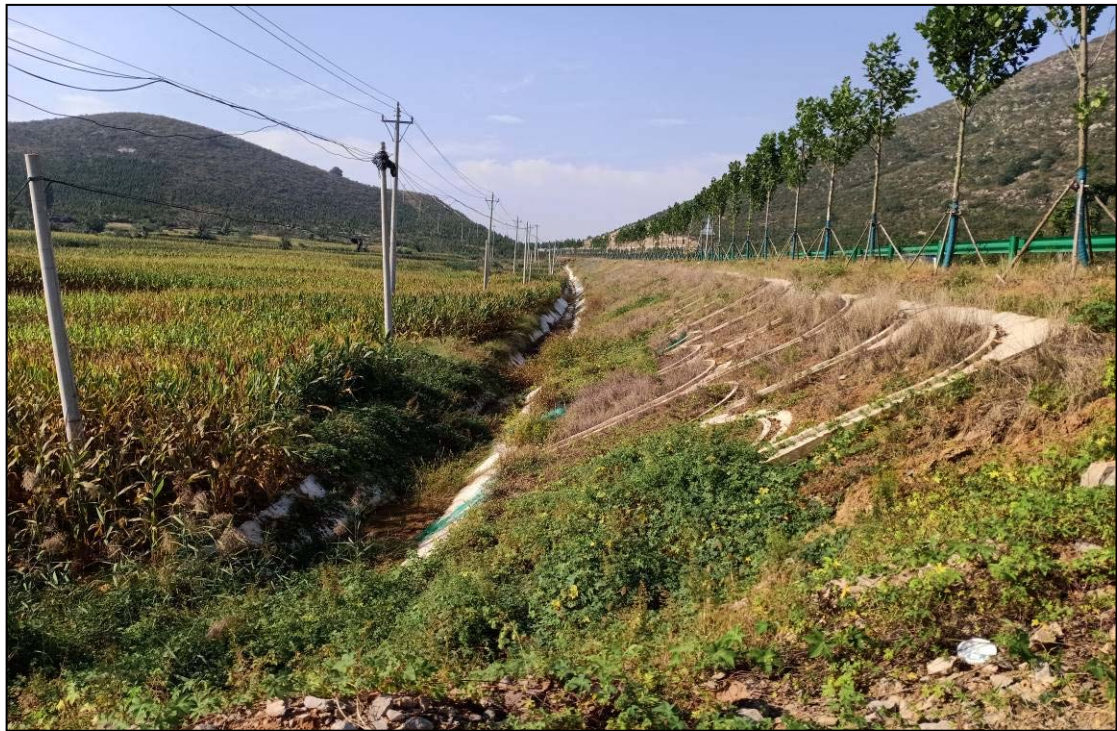
路基工程区拱形护坡及排水沟
