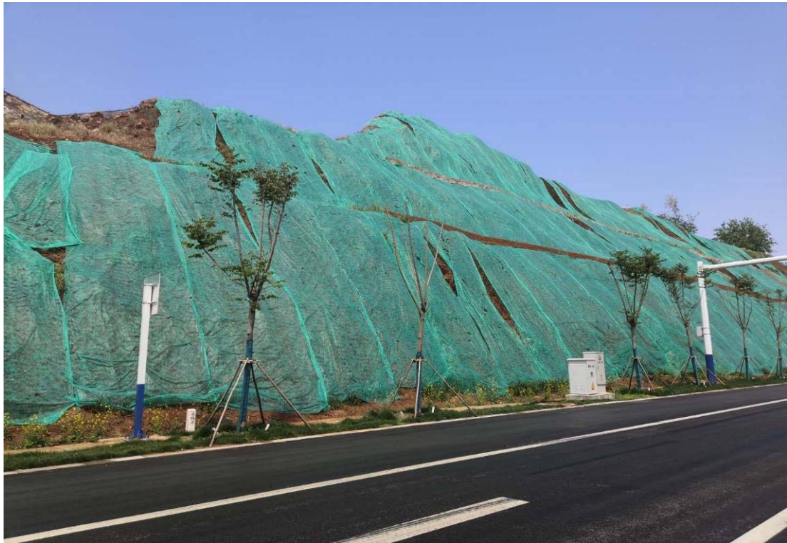
护坡施工密目网遮盖
