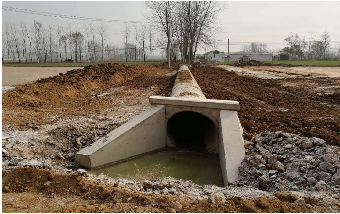
路基工程区雨水管
