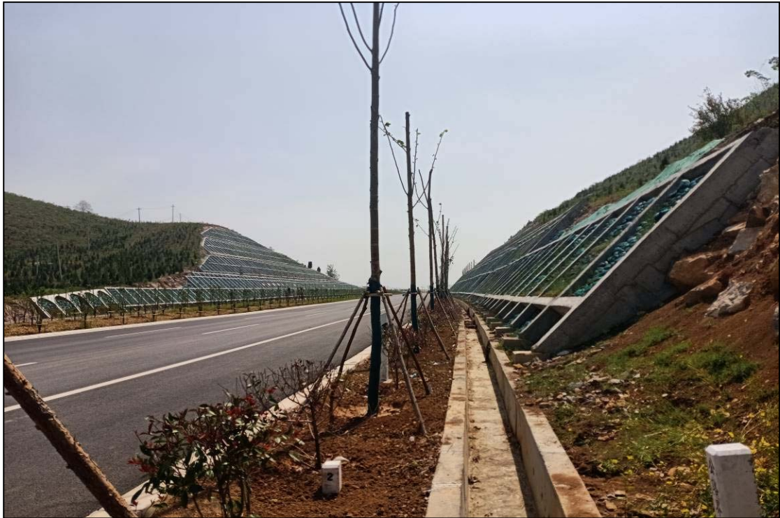
路基工程区砼拱形护坡
