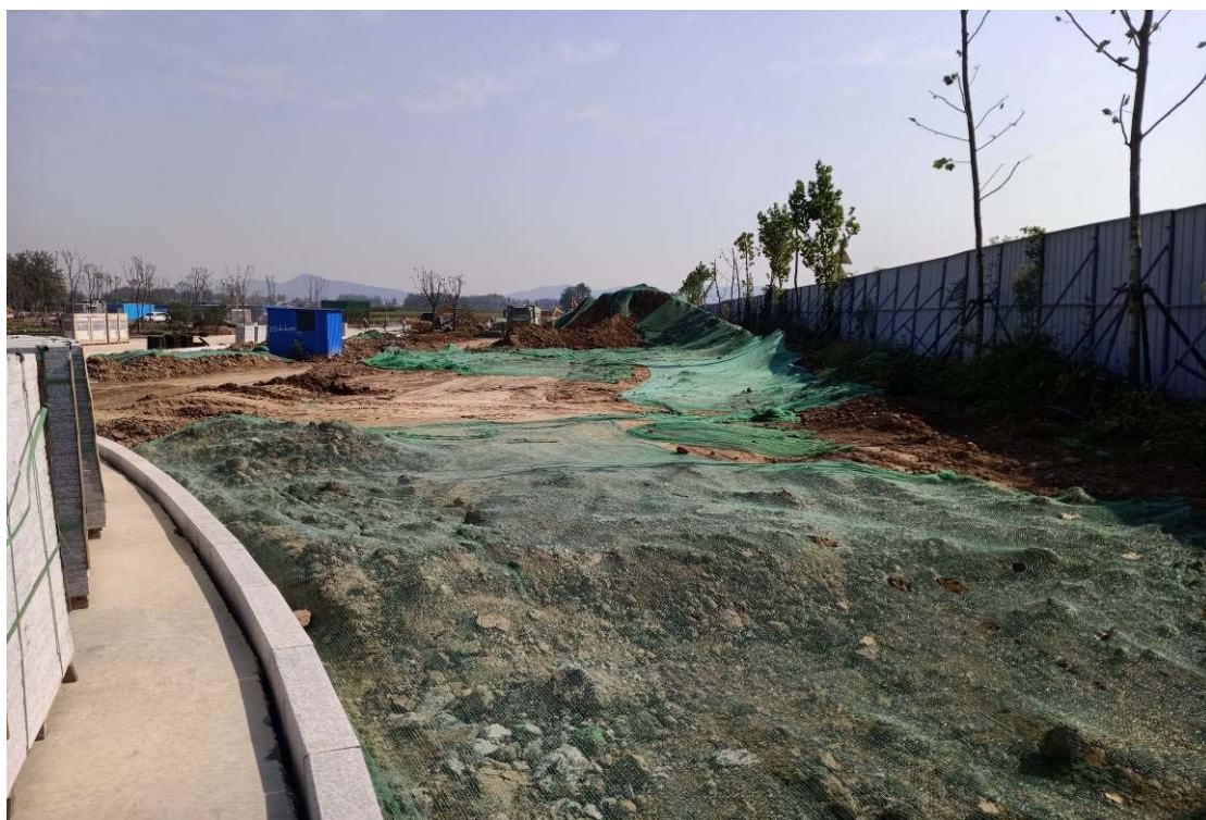
服务区施工临时堆土密目网遮盖
