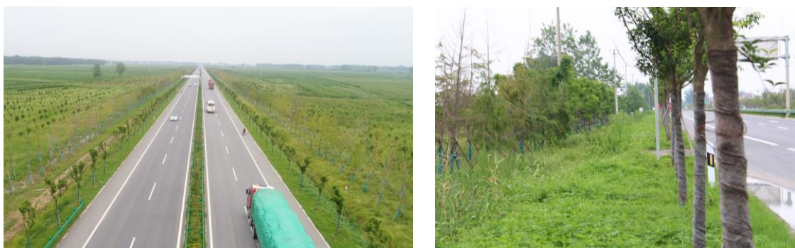
图 1.4 路基边坡植被防护
